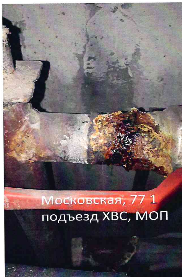
Коррозионные отложения оцинкованного стального трубопровода
