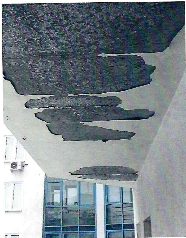
Повреждения мокрого фасада
