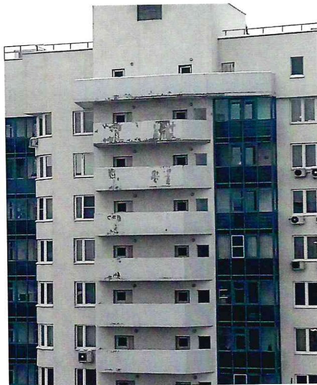
Повреждения мокрого фасада
